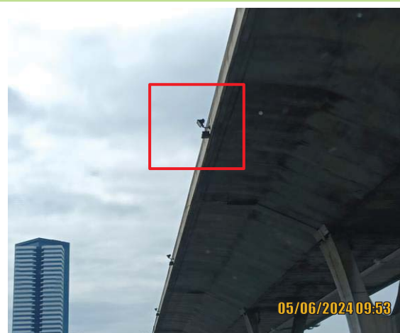
รูปที่ 3.1-5 ไฟส่องสว่างบนทางพิเศษ และบนถนนที่มีทางพิเศษคร่อม
